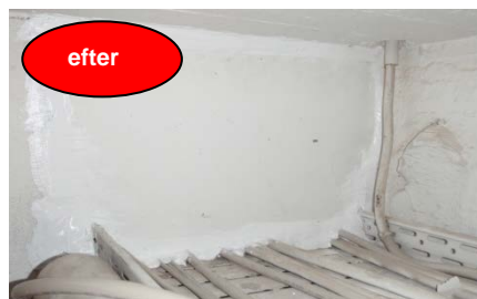
Større huller lukkes med brandplade. monteret med brandmastik
